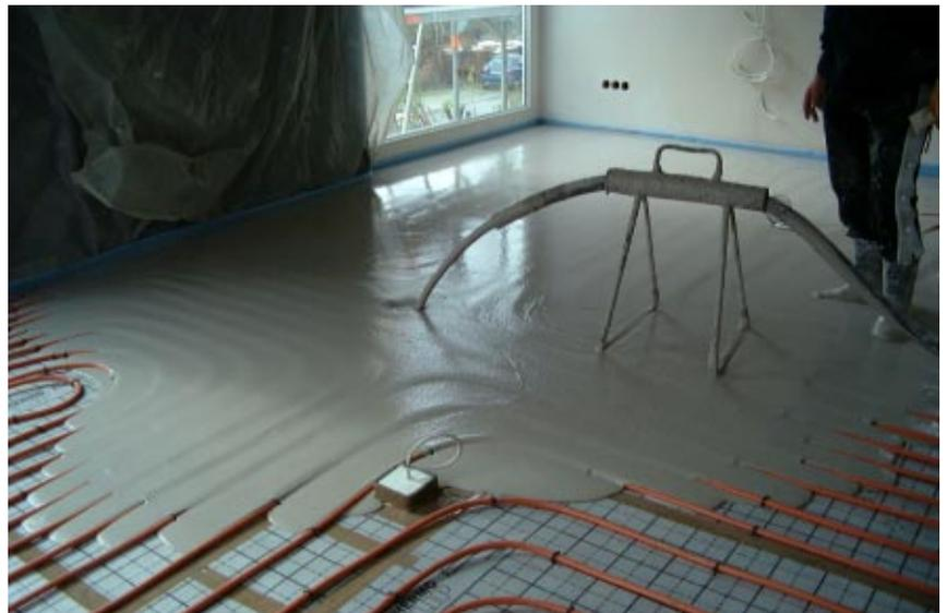
*Dieses Bild veranschaulicht deutlich die mechanischen Beanspruchungen des Fußboden-Heizsystems THERMOCLIP während der Estrich-einbringung. Es ist wichtig, daß vor, während und nach dieser Bauphase die verlegten Heizrohre sicher und zuverlässig auf der Dämmung fixiert sind. Mit den speziellen THERMOCLIP Rohrhaltern und der extrem reißfest beschichteten Dämmplatte kein Problem!*
