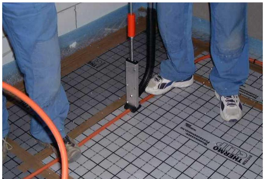
*Vor der Einbringung des Estrichs müssen Estrichmesstellen-Sets positioniert werden. An diesen Stellen kann vor der Verlegung des Oberbodens die vorgeschriebene Restfeuchtemessung des Estrichs vorgenommen werden, ohne ein im Estrich eingegossenes Heizrohr zu verletzen.*
