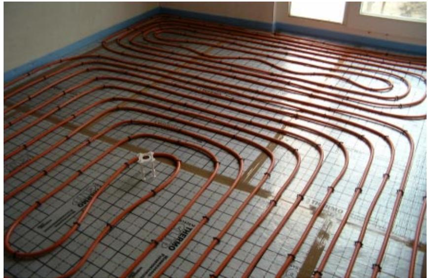
*Das System THERMOCLIP während der Einbringung des Fließestrichs.*
