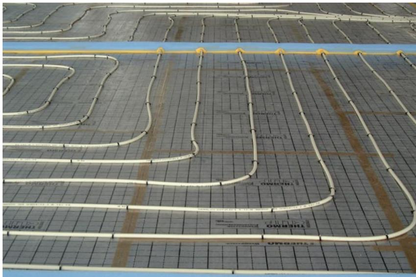
Die einzelnen Estrichfelder wurden anschließend vom Estrichleger mit Anhydrit-Fließestrich verfüllt. Durch die spezielle Ausgestaltung der patentierten **THERMOCLIP**-Rohrhaltenadeln sind die Heizrohre sicher auf der mit einer hochfesten Gewebefolie kaschierten **THERMOCLIP**-Faltplatte fixiert. Ein Aufschwimmen der Heizrohre im dünnflüssigen Estrich wird somit wirkungsvoll verhindert.
