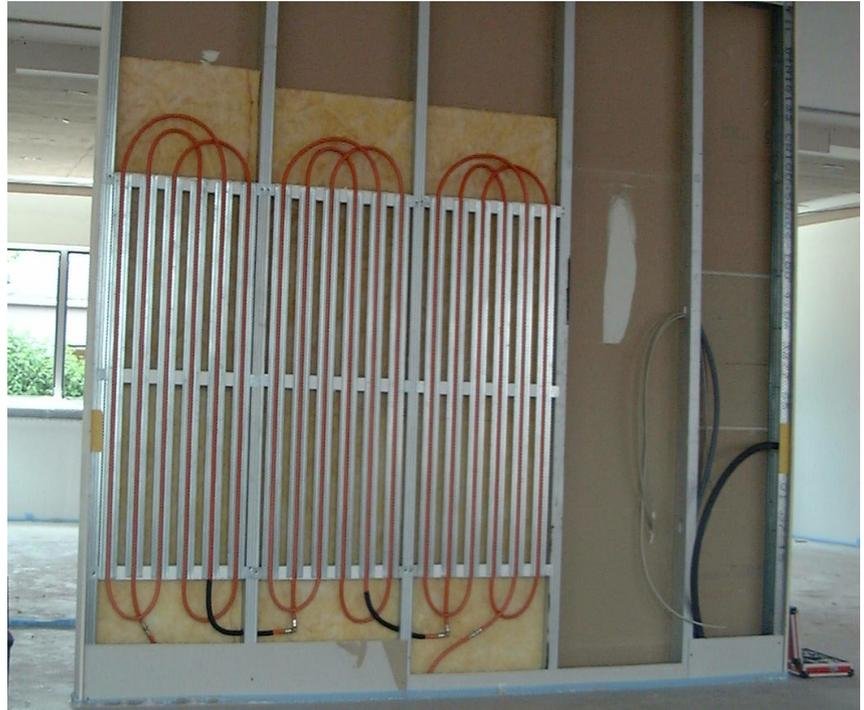
*Die vorgefertigten Wandheizmodule erlauben kürzeste Montagezeiten. So betrug der Zeitaufwand für die Installation der 9 Wandheizmodule in diesem Objekt einschließlich Befüllen der Wand-Heizkreise 1,5 Stunden! Hinter den Wandheizmodulen sind zur Isolation gegen die Wandrückseite 4 cm dicke Mineralfaserplatten angebracht.*
