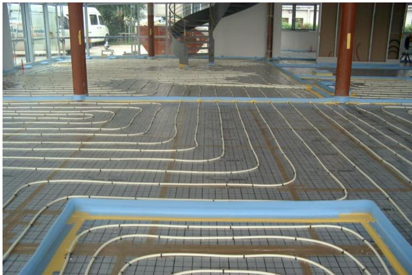
Bei Heizleitungen, die Bewegungsfugen durchquerten, wurde das **THERMODEHN** Dehnfugenprofil an der Unterkante ausgeklinkt und auf die Heizrohre aufgestellt. Die Heizrohre wurden in diesem Bereich durch ein ca. 25 cm langes, flexibles Schutzrohr durch die Bewegungsfuge geführt.
