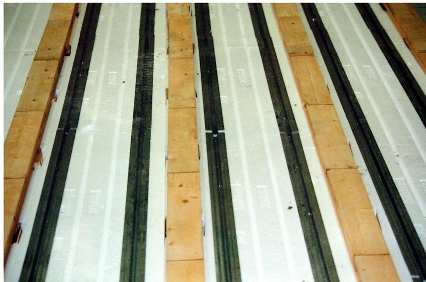
*Durch diese Systemtechnik konnte ein Heizrohrabstand von 25 cm ( $4 \text{ lfm/m}^2$ ) mit dem Systemheizrohr Diffuflex-S aus Polybuten in den Abmessungen  $14,5 \times 1,8 \text{ mm}$  realisiert werden. Andere Systeme arbeiten hier mit einem unvergleichlich dichteren Rohrabstand (= mehr Rohr pro  $\text{m}^2$ ) und wesentlich größeren Rohrdurchmessern ( $> 18 \text{ mm}$ ).*
