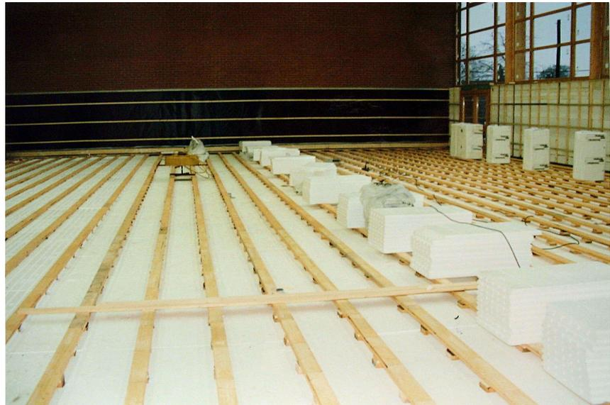
*Mit der Warmwasser-Fußbodenheizung THERMOLUTZ System NE/TE-S kann diese Forderung leicht erfüllt werden: Omegaförmige Wärmeleitbleche aus verzinktem Stahlblech umgeben das Kunststoff-Systemheizrohr umfangschlüssig und leiten die Wärme in die darüberliegende Abdeckung aus kunststoffbeschichtetem Stahlblech.*
