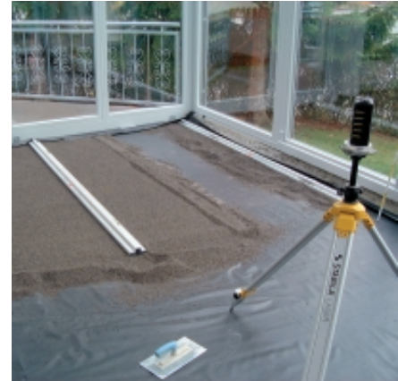
Die Trockenschüttung wird in einer Schichtdicke von 2 - 3 cm mit Hilfe von Abziehlehren planeben abgezogen
