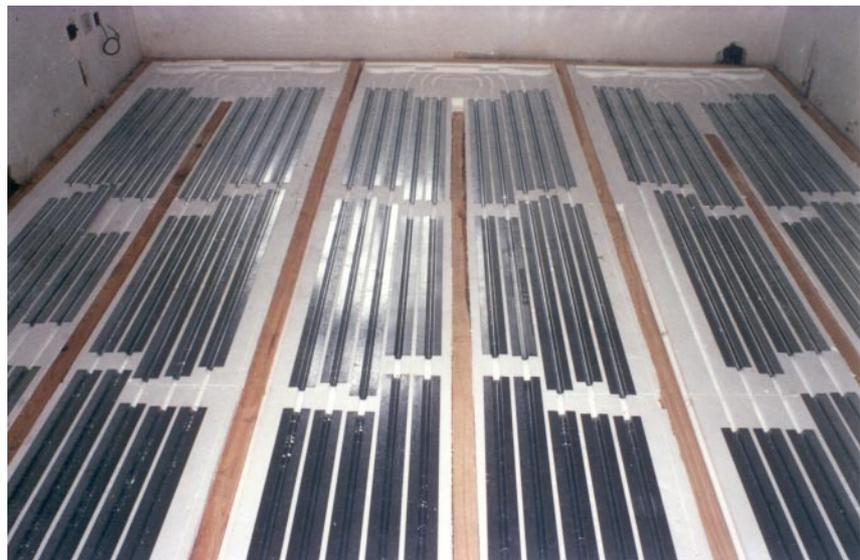
Die omega-förmigen Wärmeleitbleche aus verzinktem Stahlblech umgeben das Kunststoff-Systemheizrohr umfangschlüssig und leiten die Wärme in die darüberliegende Abdeckung aus verzinktem Stahlblech. Nun kann der Holzdielenboden in gewohnter Weise auf die Lagerhölzer fixiert werden.
