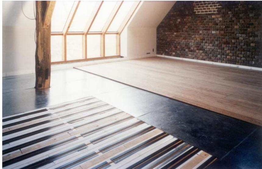
Die THERMOLUTZ Systemelemente in den Abmessungen 50 x 100 cm werden zwischen die Lagerhölzer des Dielenbodens eingepasst. In die Rillen der Polystyrol-Systemelemente werden die speziellen Wärmeleitbleche eingelegt, die wiederum das hochtemperatur-beständige Kunststoff-Heizrohr aufnehmen.
