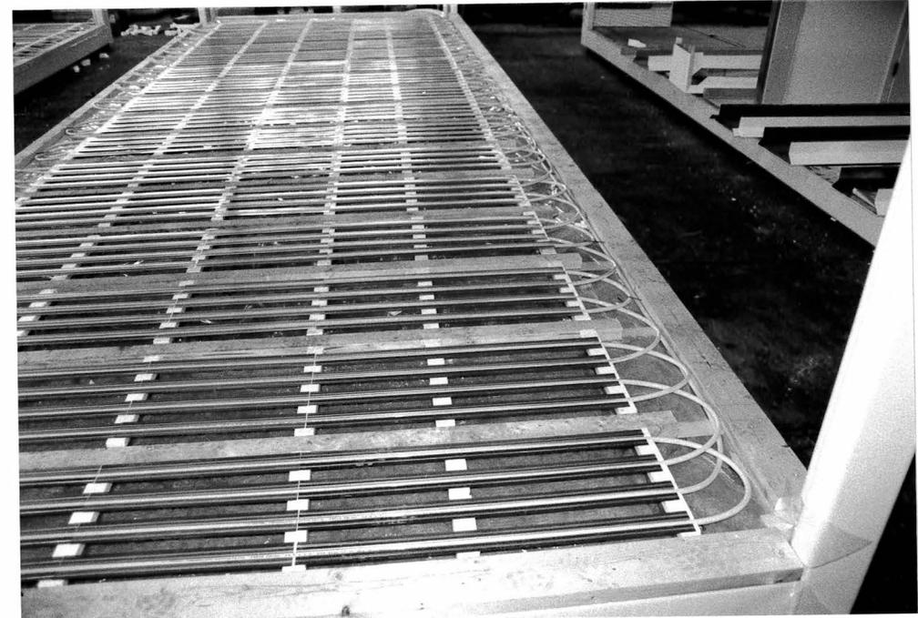
THERMOLUTZ Fußbodenheizung System Econom-Flex zum Einbau in Modulgebäude-Wohneinheiten
