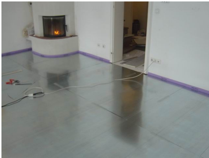
Bild 21: Abdeckbleche verlegt
