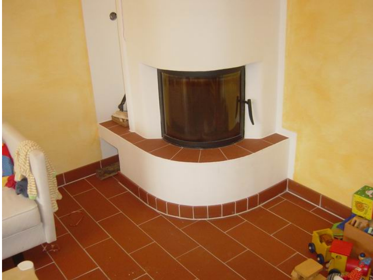
Bild 23: Sockel-Ziegel verlegt und verfugt
