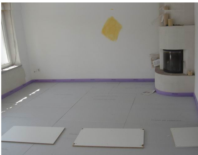
Bild 19: Ausgelegte Zusatzdämmung
