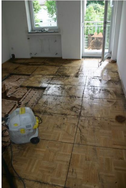
Bild 17: Der zerschnittene Parkett-/Asphalt Fussbodenaufbau
