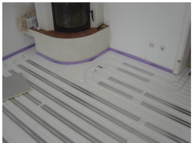
Bild 20: Systemplatten und Rohre verlegt
