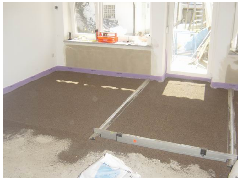
Bild 17: Einbringen der Trockenschüttung
