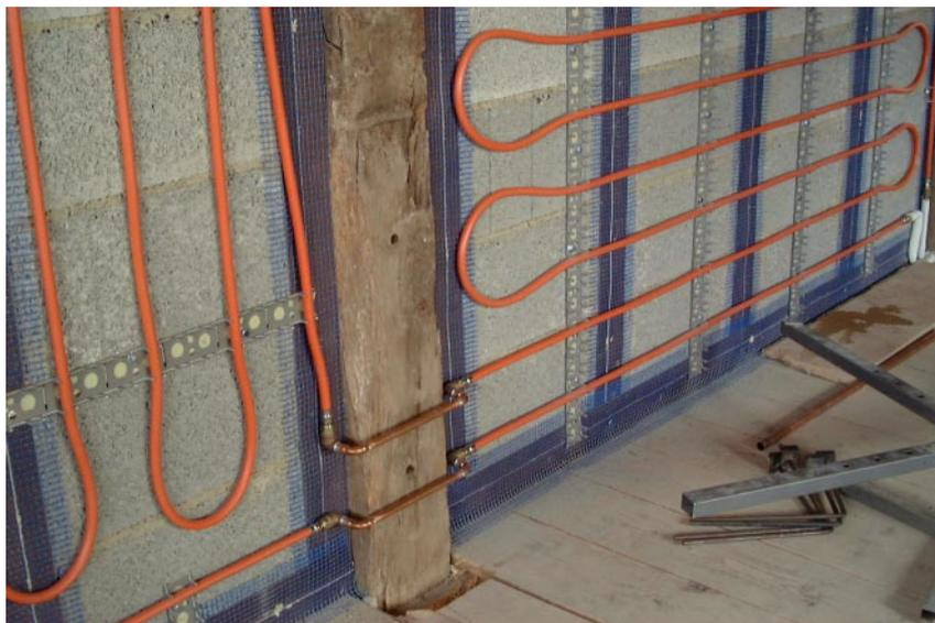
*Gut sichtbar das Putzgittergewebe, das über die Holzbalken des Fachwerks gelegt wird. Hierdurch sollen Spannungsrisse der Putzlage vermieden werden.*
