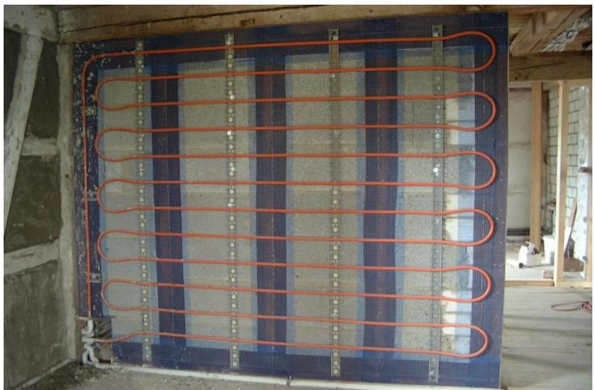
*Die aus der Wandoberfläche herausragenden Holzbalken werden mit Kupferbögen übersprungen. Die Übergänge auf das Metall-Kunststoff-Verbundrohr erfolgen mit Pressfittings.*
