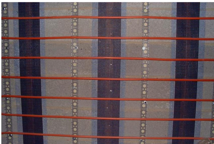
*Montage der Zahnschienen auf das Mauerwerk*
