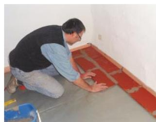
Schwimmend verlegter Trocken-Estrich aus 20 mm dicken CREATON Estrich-Ziegeln.
