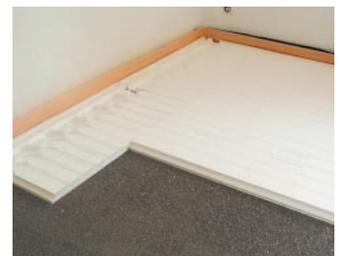
Die Systemplatten der THERMOLUTZ Fußbodenheizung NE/TE werden direkt auf der Schüttung verlegt.
